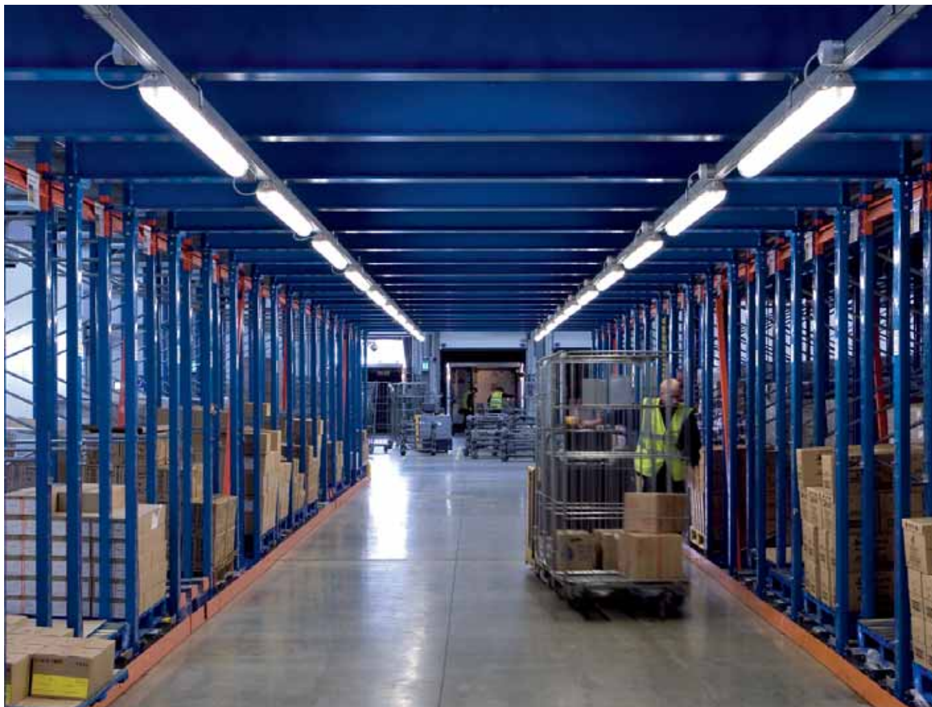
Svítlidla ImpactForce byla umístěna do skladu a mezi regály, protože jsou robustní a odolávají nárazům a vibracím.
